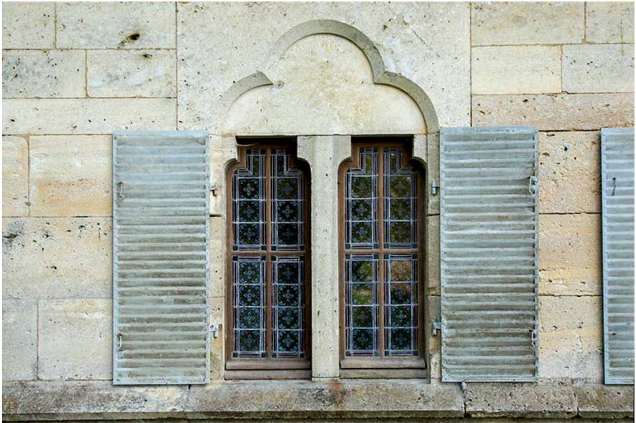
Détail : baie du rez-de-chaussée.
