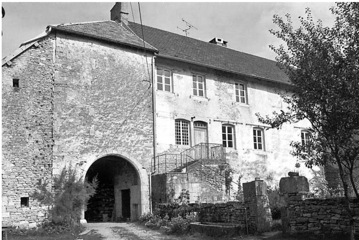
Façade antérieure et le passage voûté.
