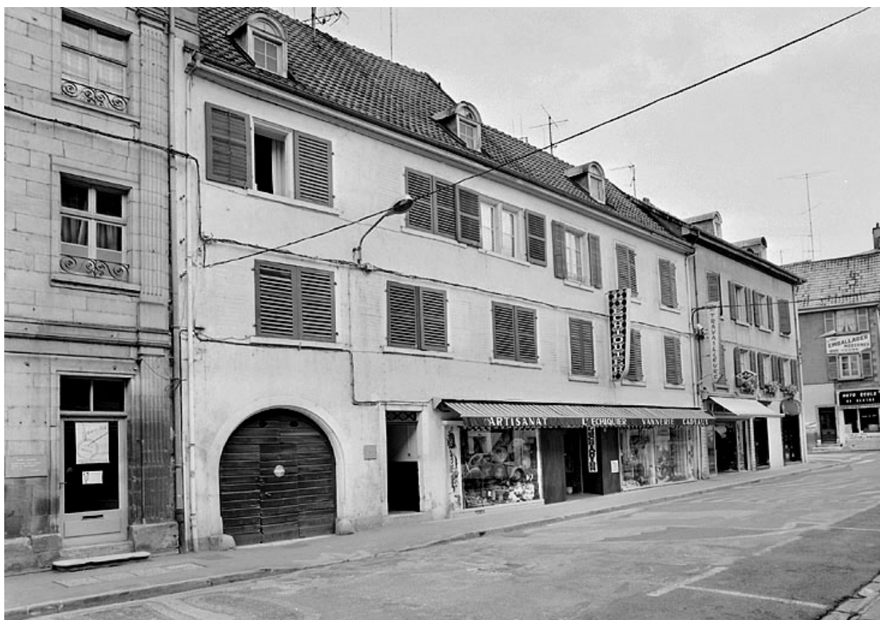
Vue d'ensemble des façades sur rue.
