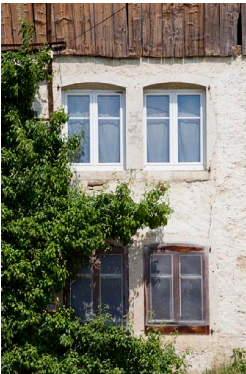
Travée de fenêtres doubles en façade.
