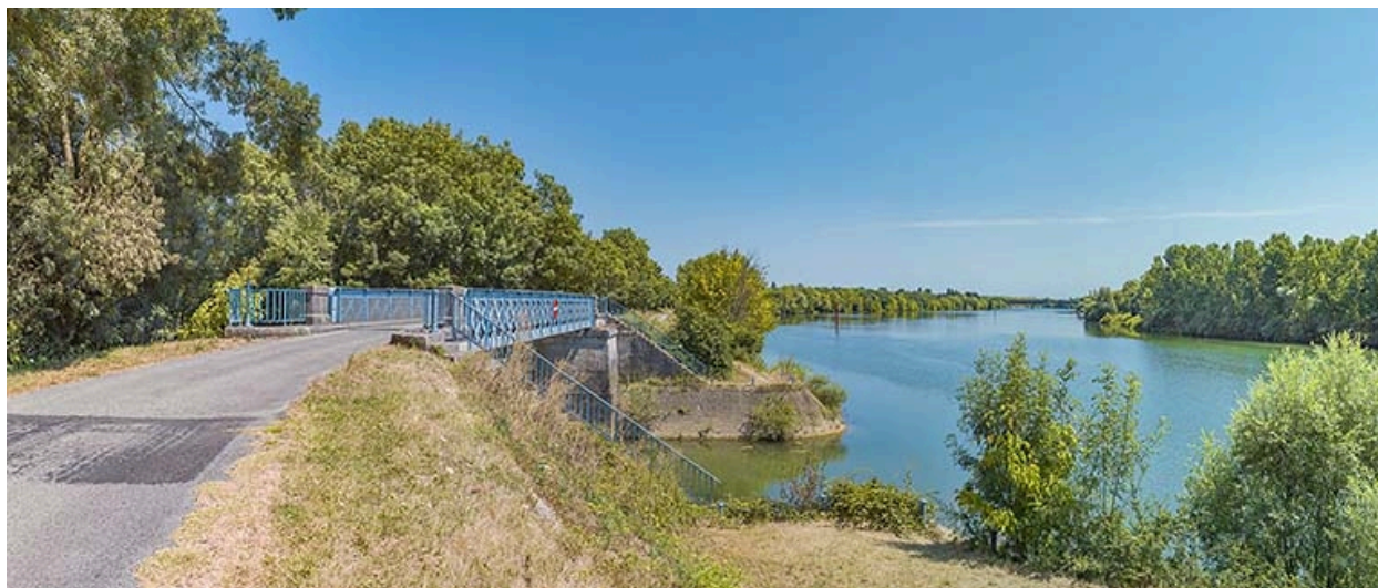
Le pont sur la Dheune, vu d'aval.
