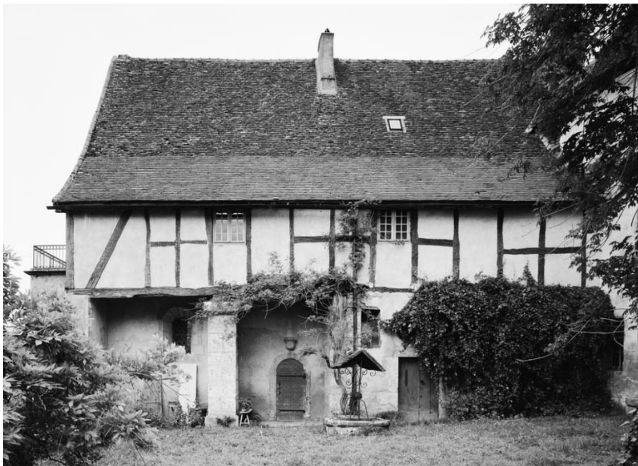
Elévation antérieure du bâtiment de la chapelle.
