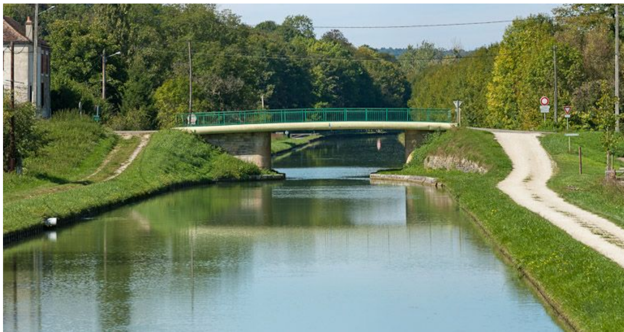
Vue du pont.
