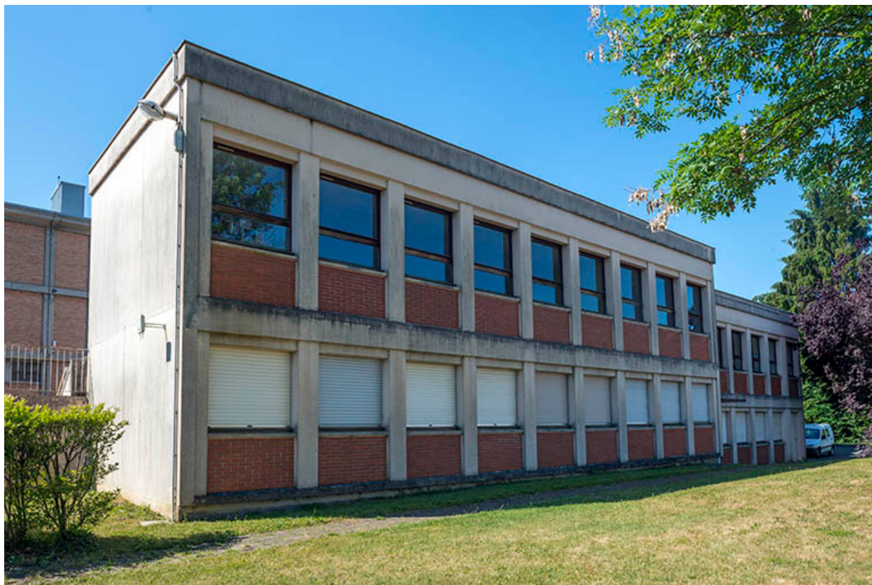
Façades antérieures (nord) du bâtiment d'externat. (ex-Garnier)
