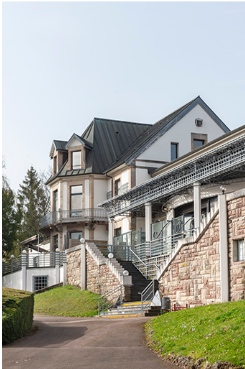
Maison, vue depuis le nord.
