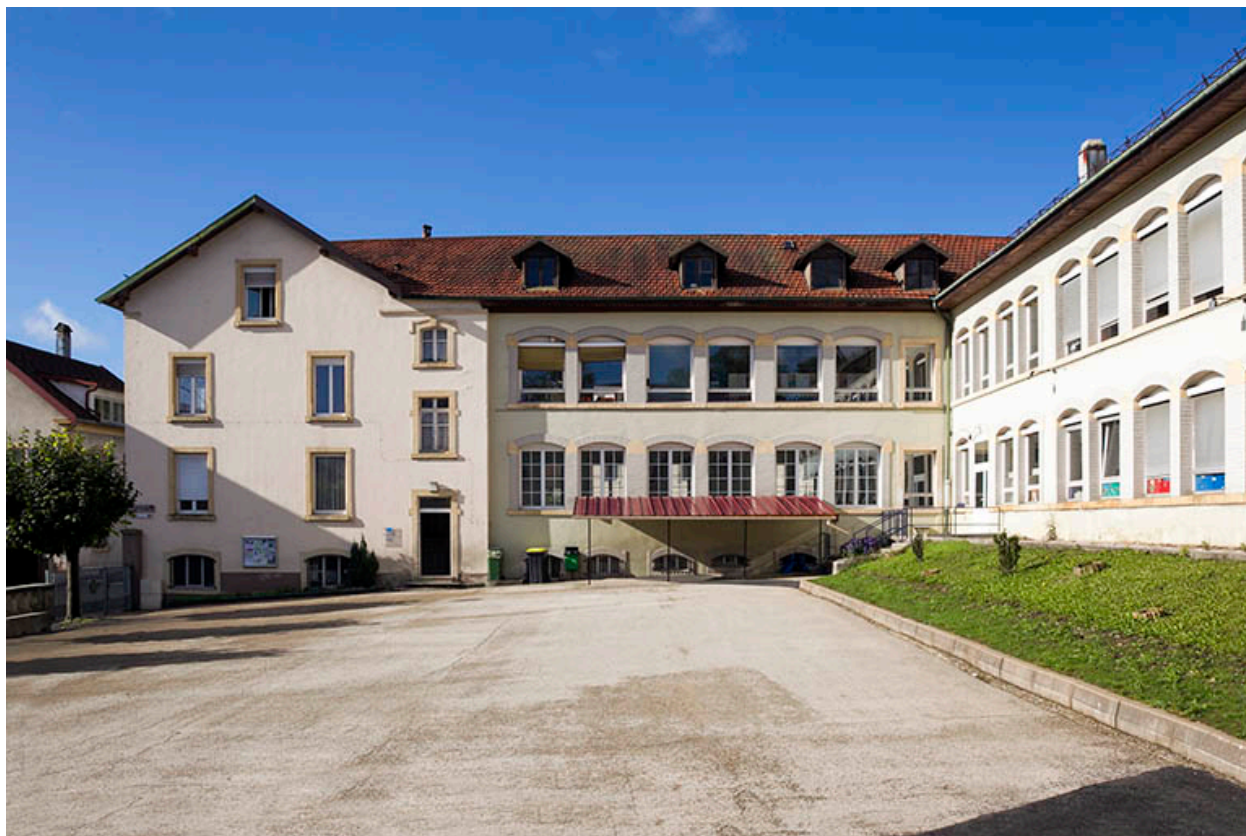
Aile ouest : façade orientale (sur cour).
