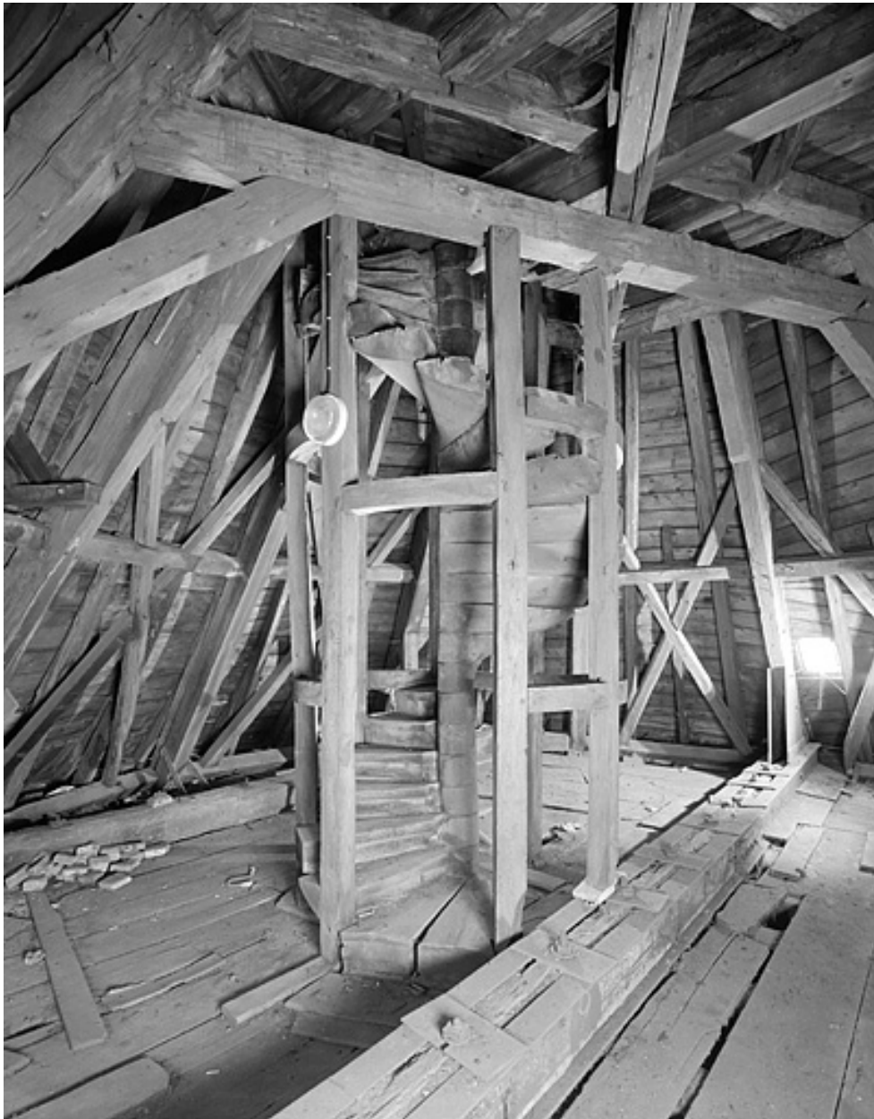
Tour Henriette. Charpente et escalier conduisant au lanteron.
