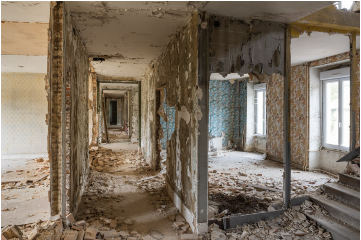
Couloir et chambres au premier étage.
