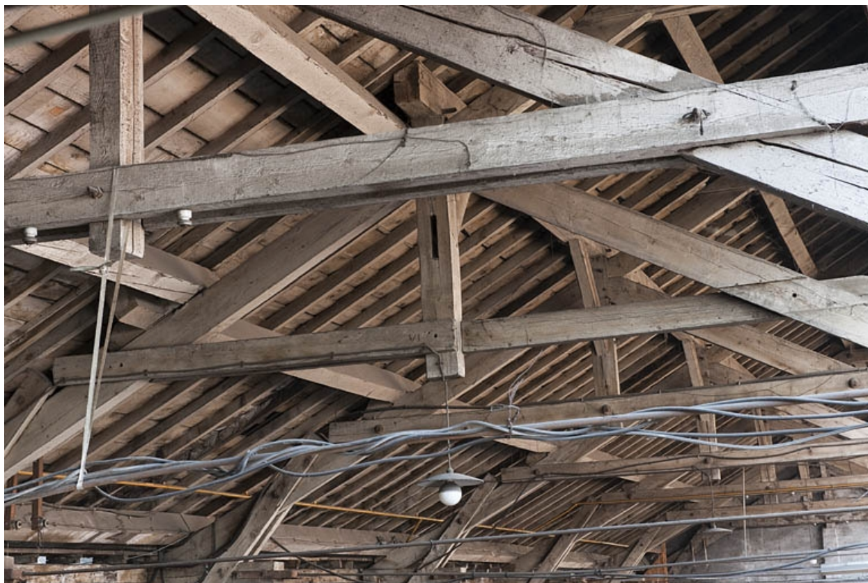
Détail de la charpente du magasin industriel.
