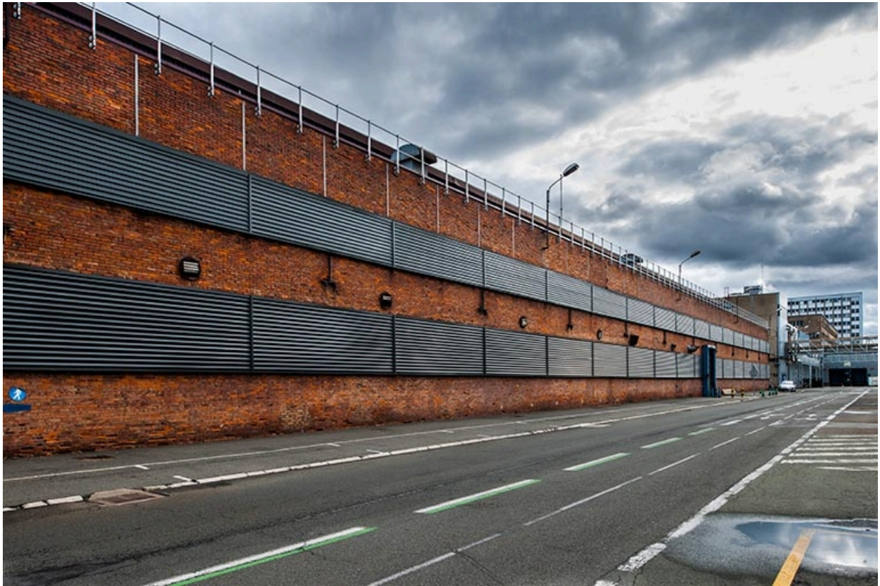
Façade ouest d'un atelier (mécanique ?).
