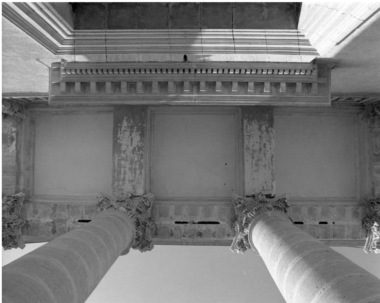
Façade antérieure : plafond de l'avant-corps central.
