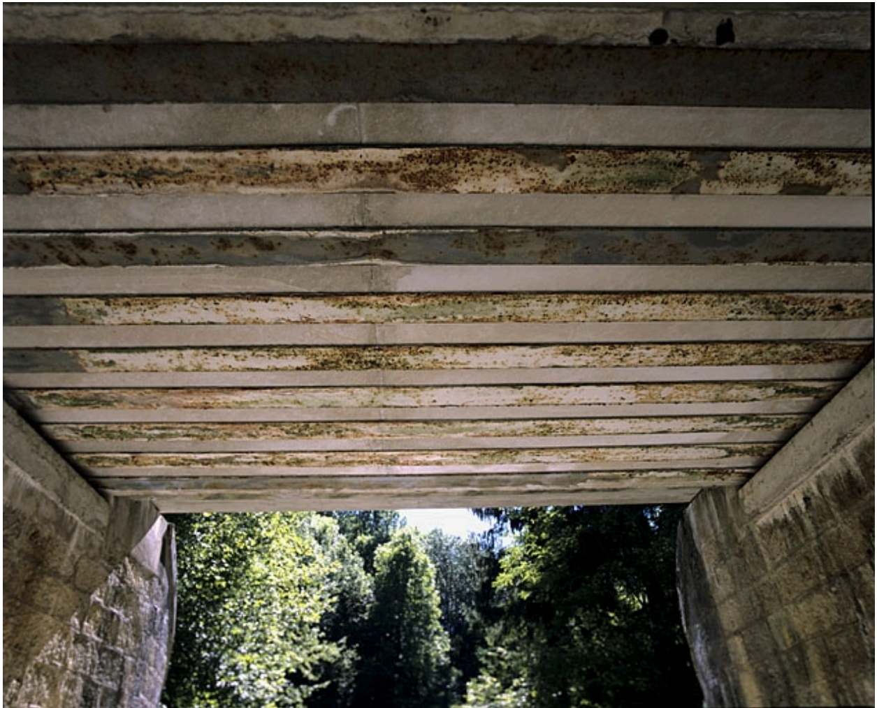
Pont : poutrelles en face inférieure du tablier.
