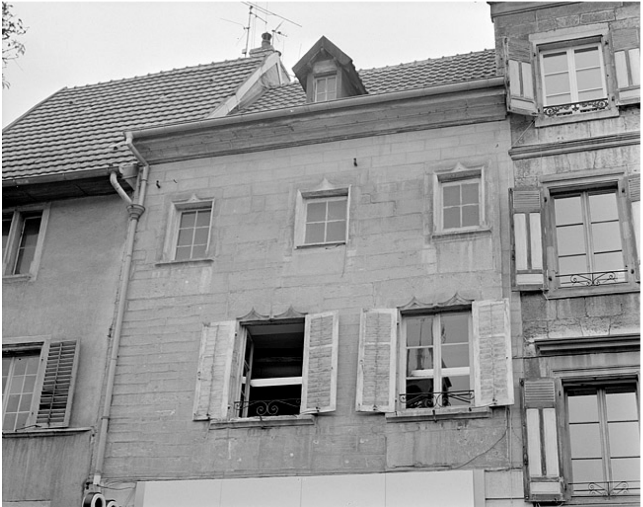
Maison 23, place Denfert-Rochereau. Vue des deuxième et troisième étages. 16e siècle.
