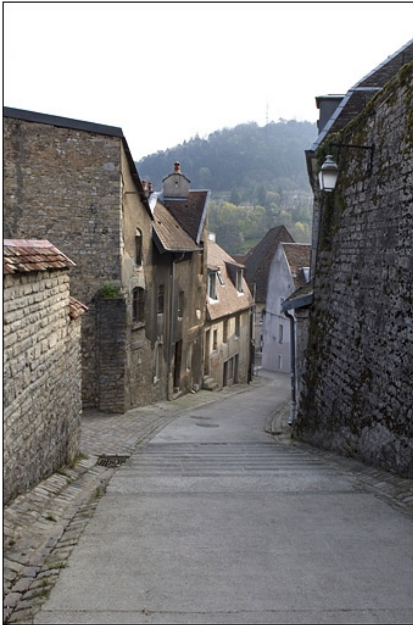
Façade latérale gauche du logis secondaire, en descendant la rue du Chambrier : vue rapprochée.
