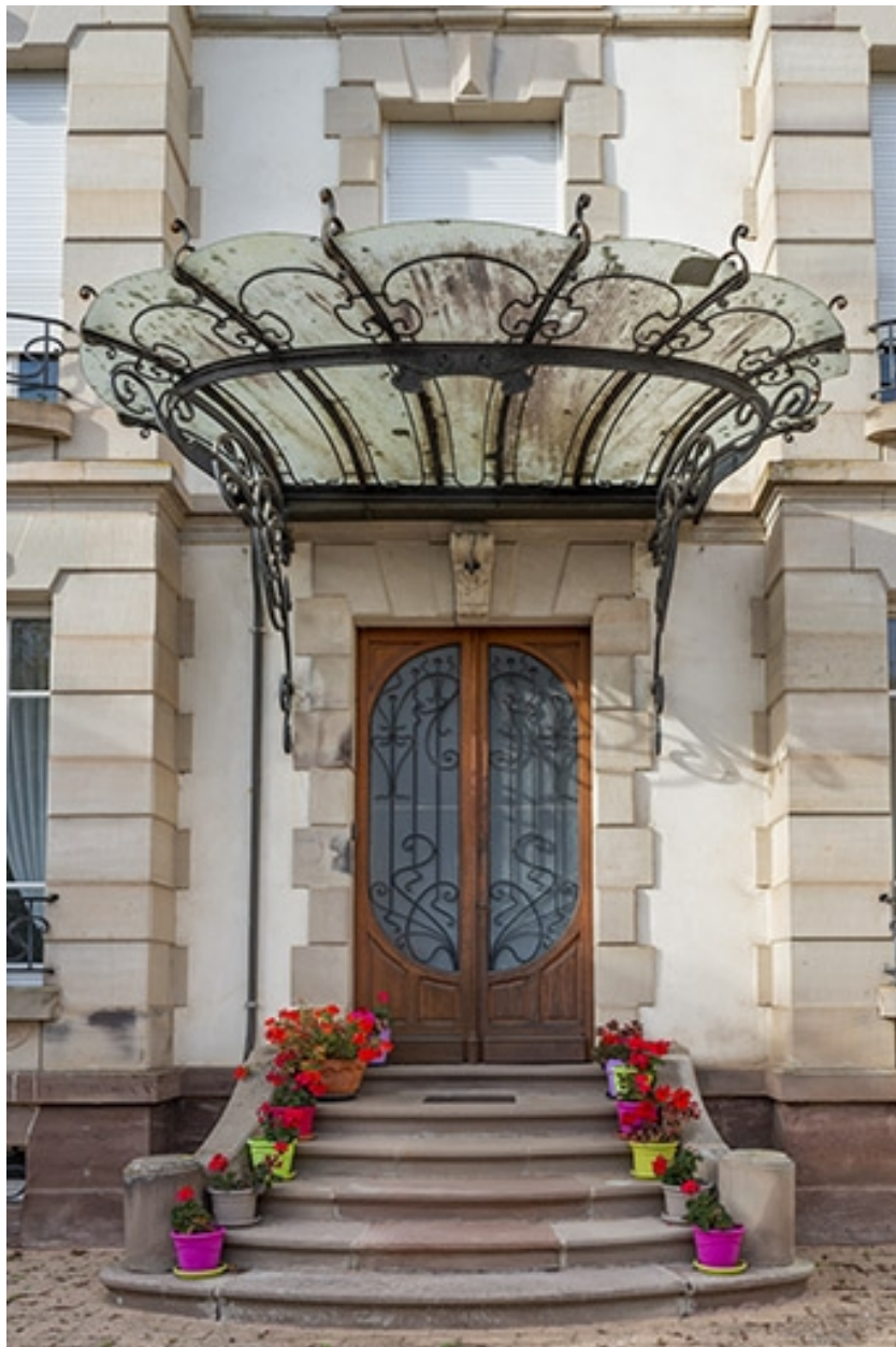
Porte d'entrée surmontée d'une marquise, vue de face.
