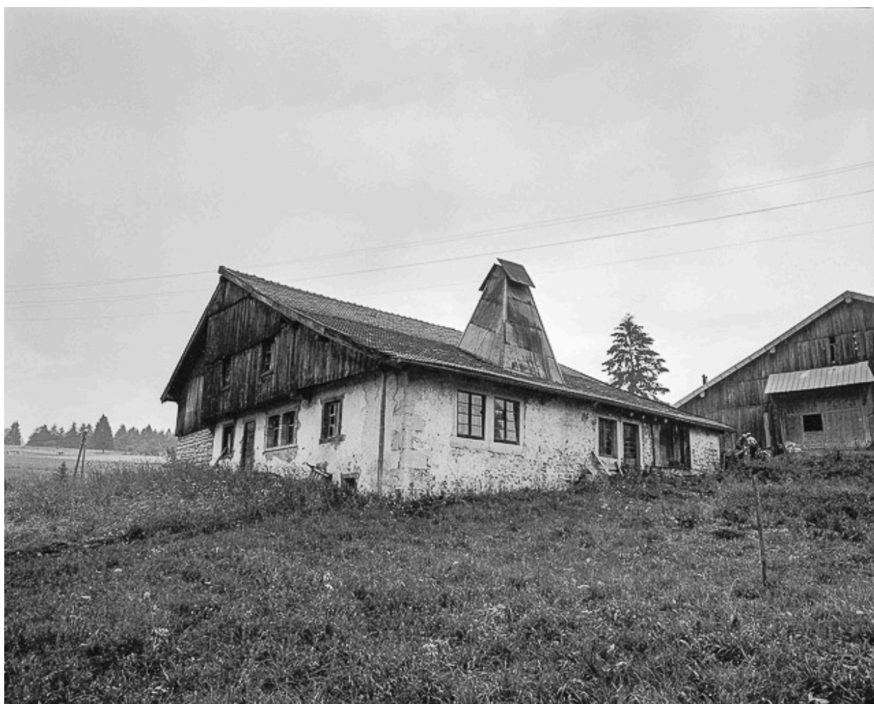
Ferme située au lieu-dit Remonot, cadastrée AC 50 : façades antérieure et latérale droite.
