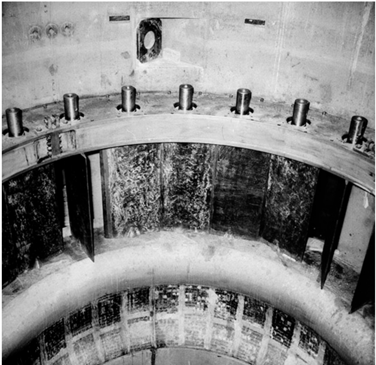
Turbine G.1 : distributeur en cours de montage.
