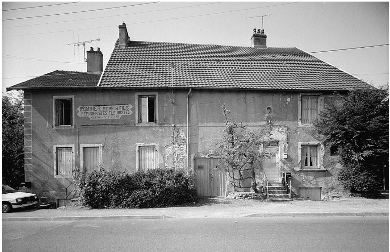
Façade antérieure, de face.
