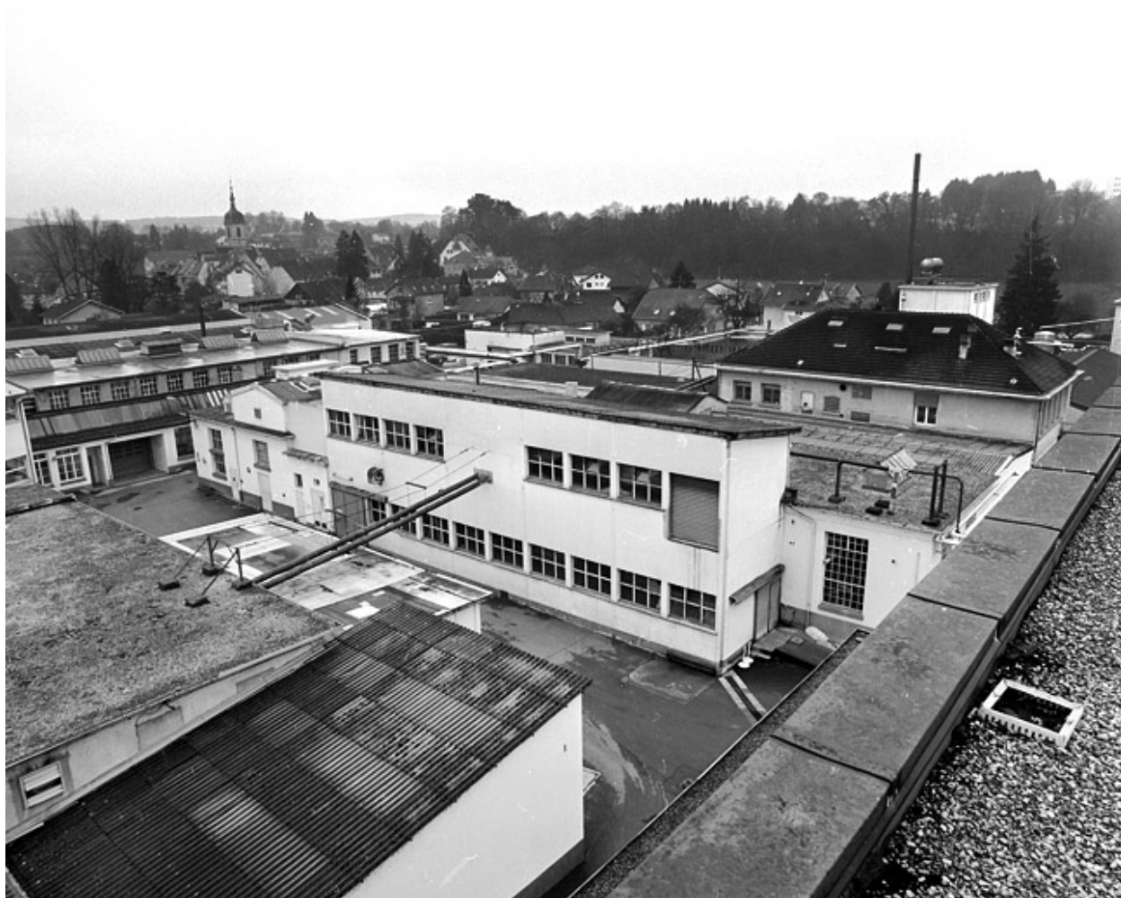
Vue plongeante vers le sud-ouest.
