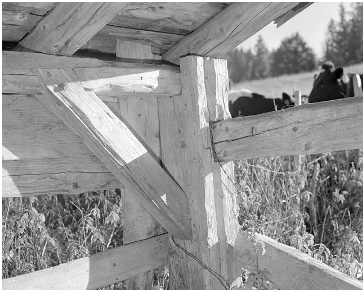
Assemblage de la charpente de l'abreuvoir.
