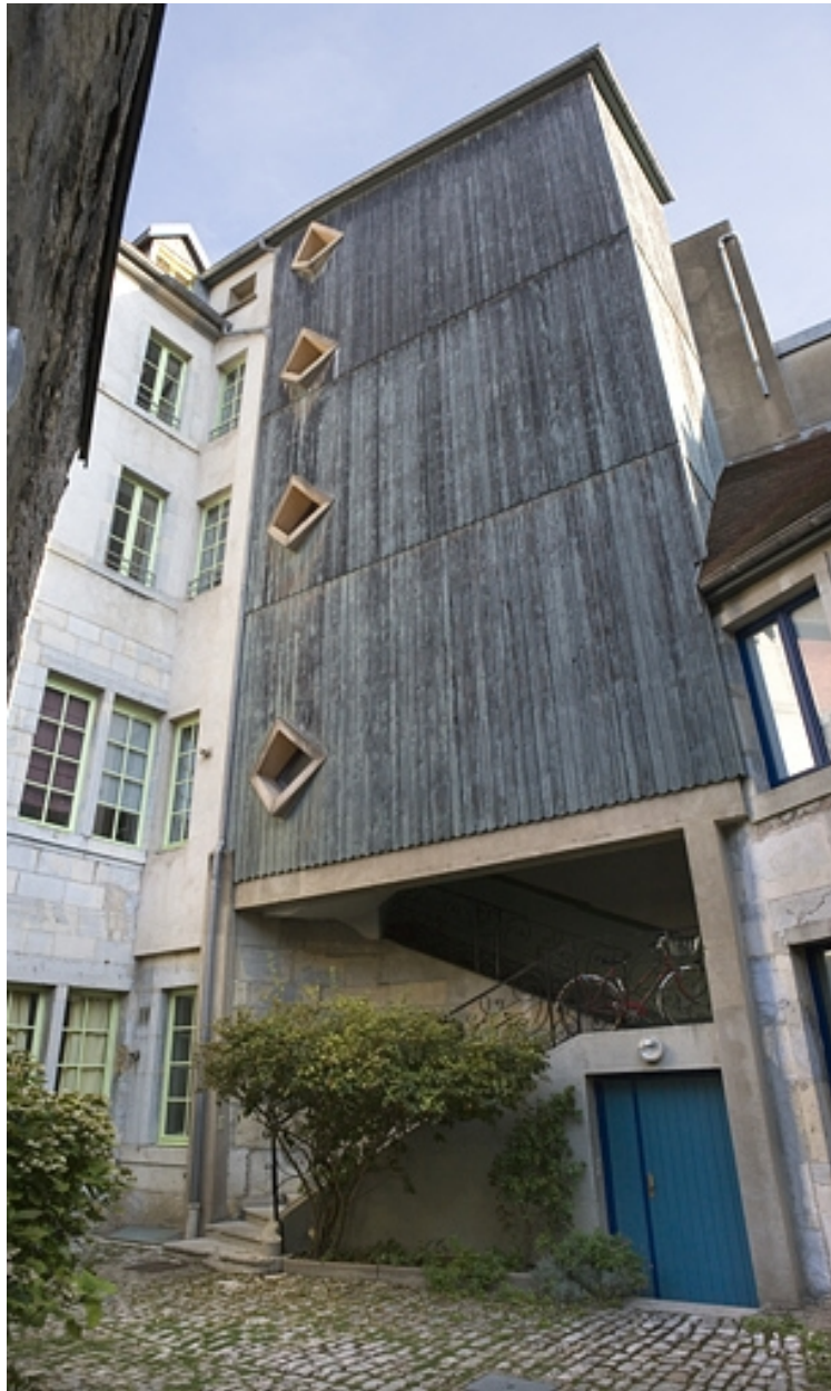
Vue d'ensemble de l'escalier à cage ouverte sur cour.
