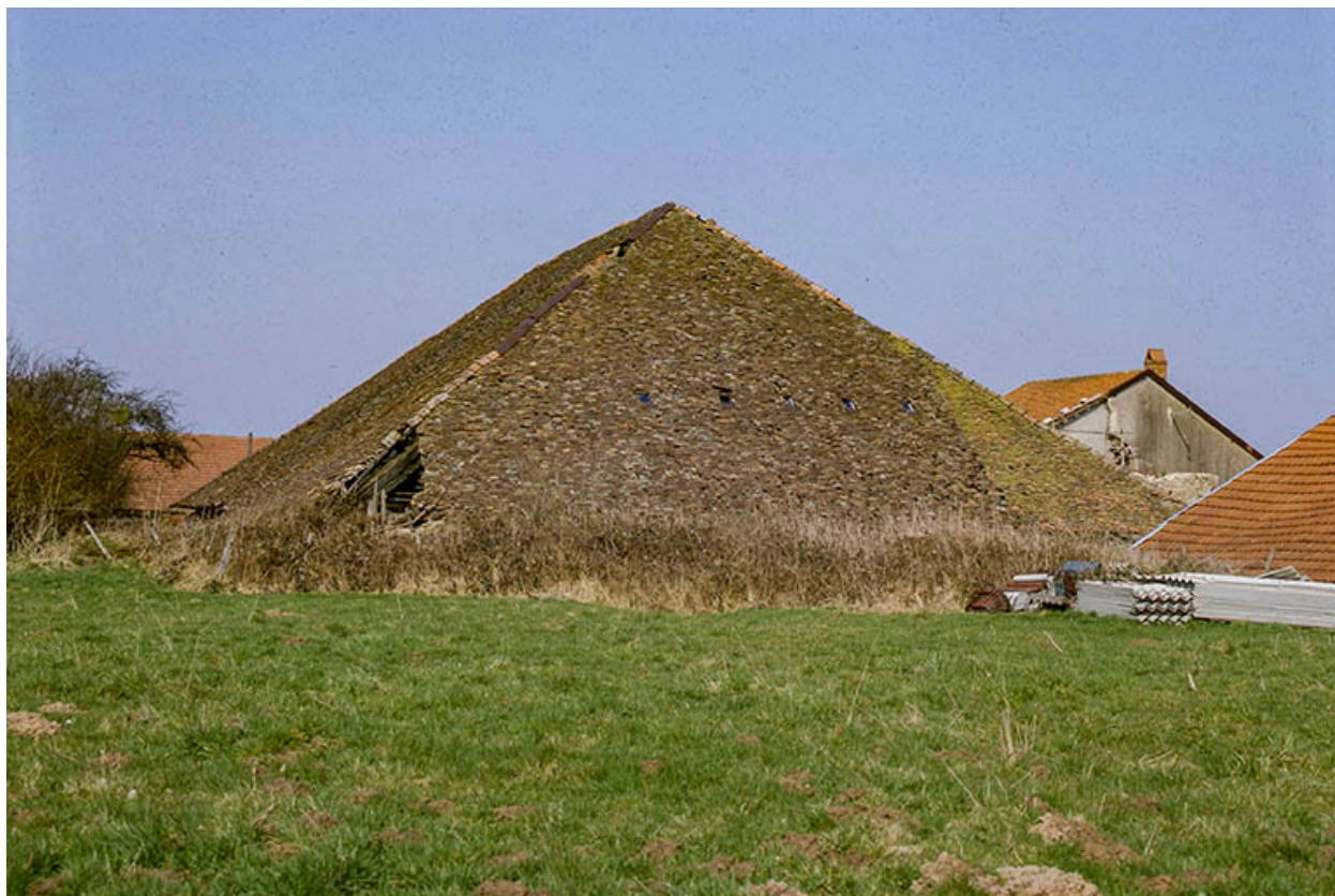
Le toit du séchoir.
