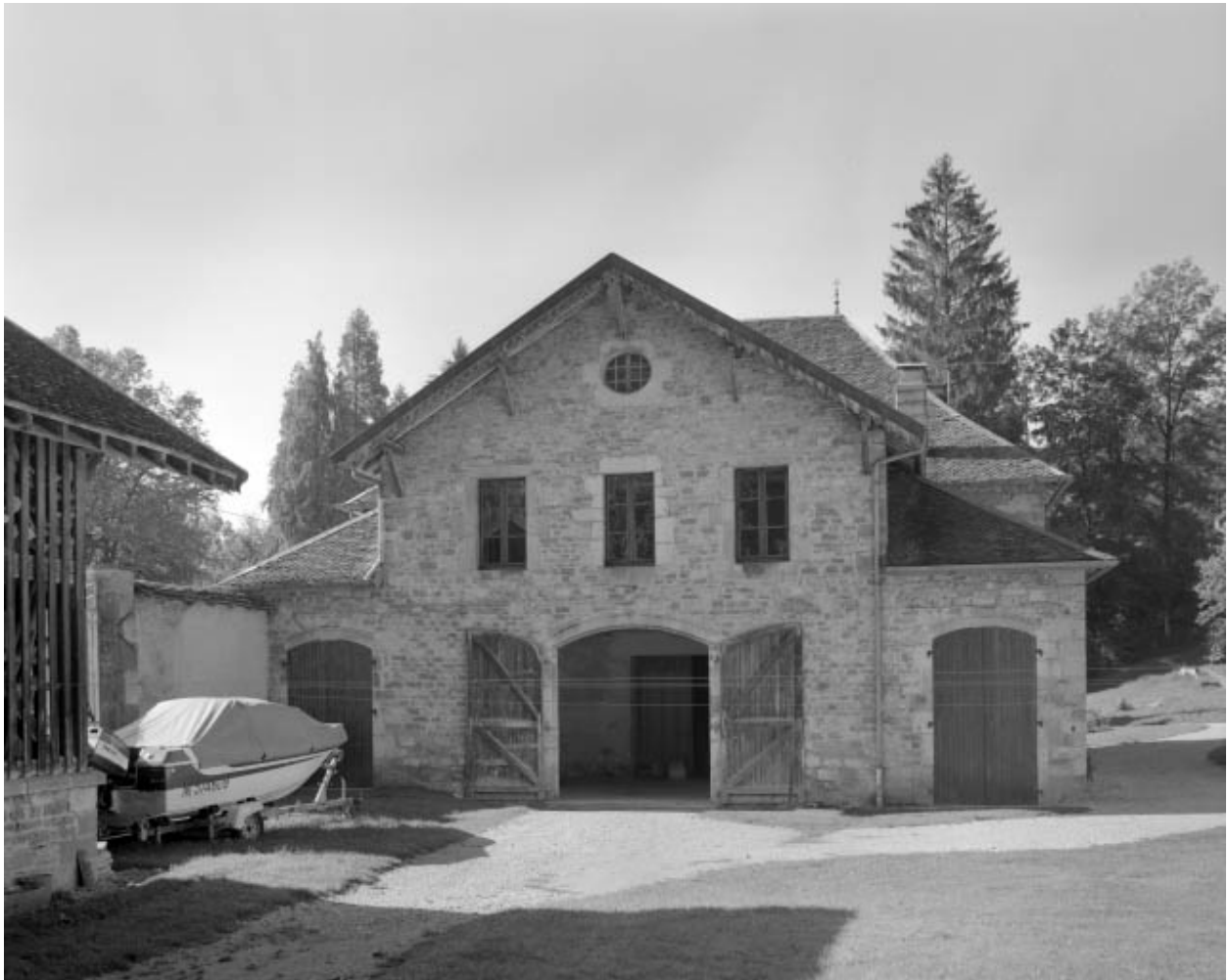
Façade postérieure du bâtiment abritant logement de domestiques et remise.
