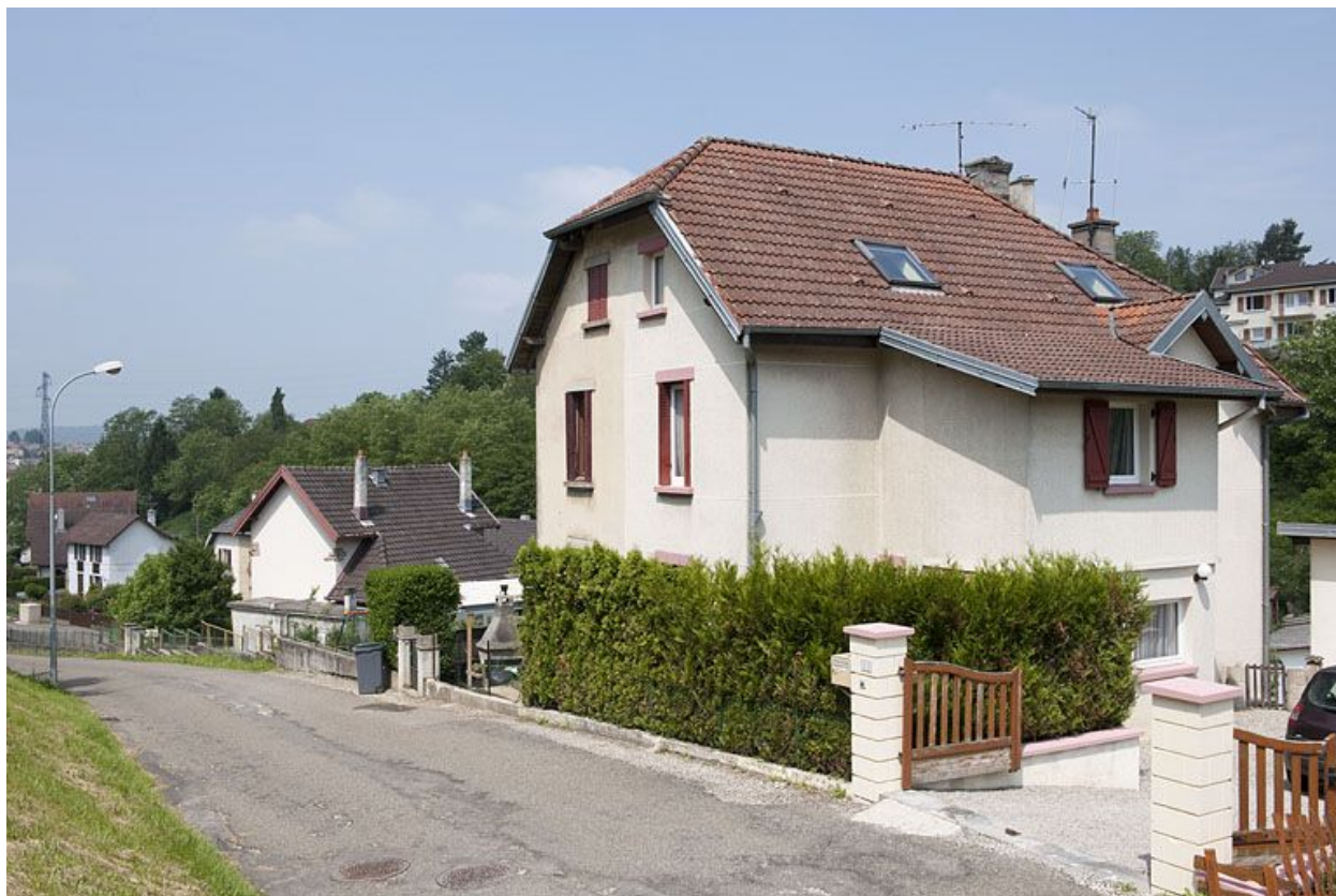
Maison jumelée. Vue de trois quarts droite.
