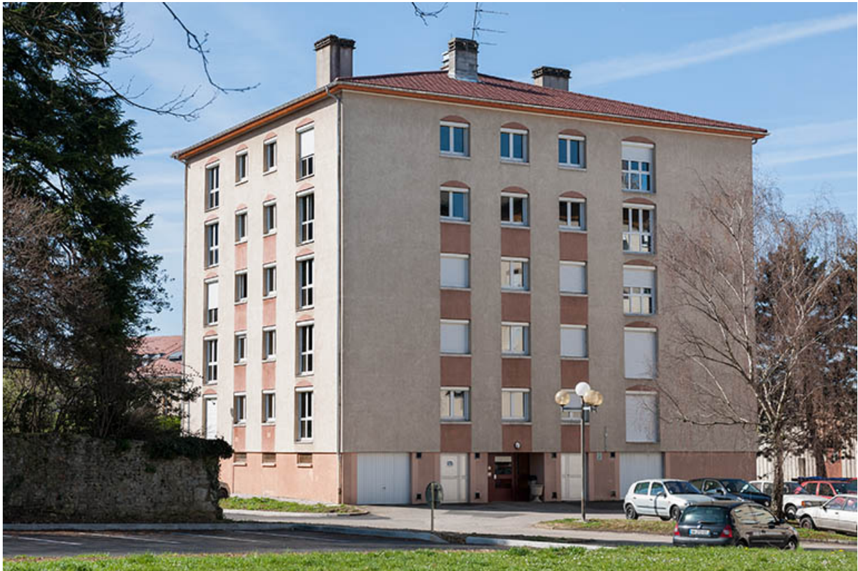
Angle nord-est, entrée du bâtiment des pinsons.
