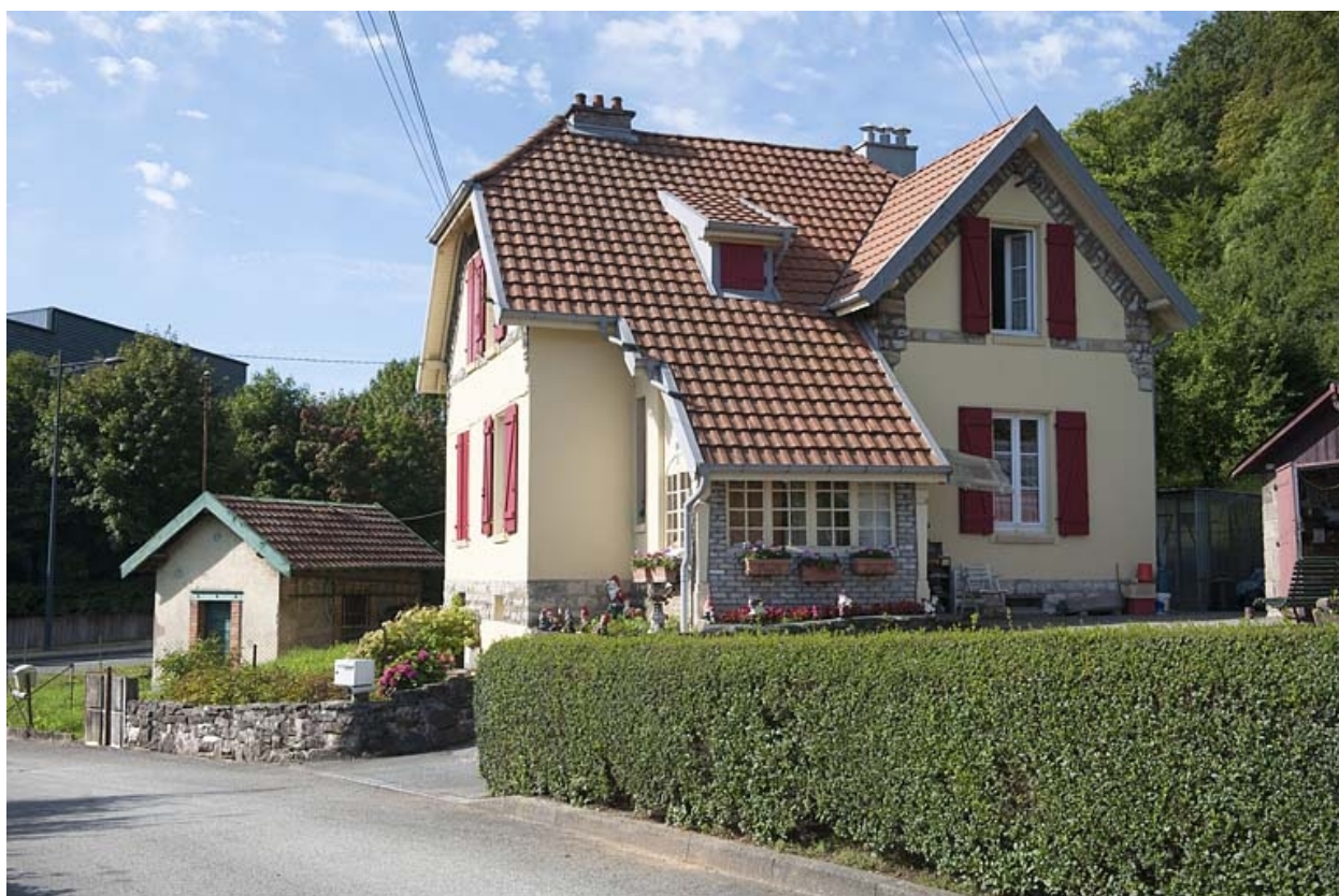
Maison jumelée. Façade est.
