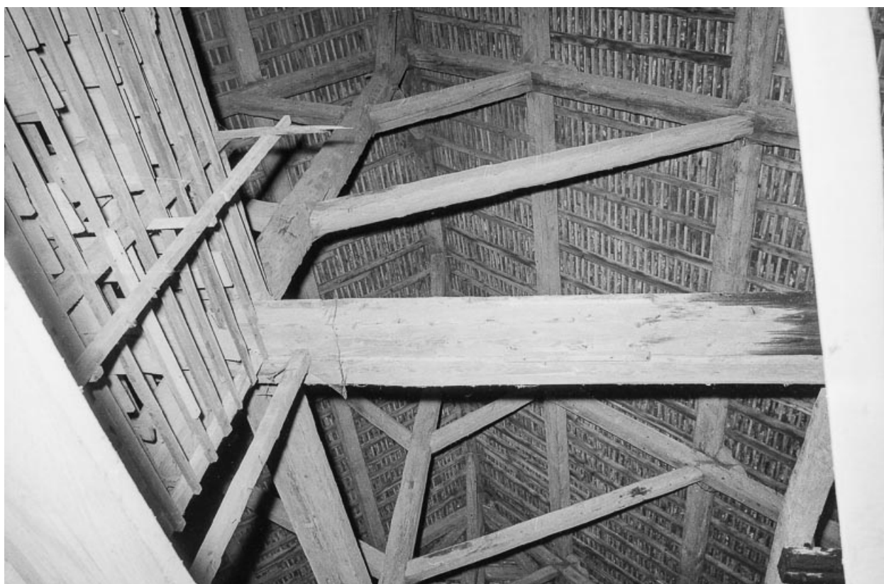
Charpente du séchoir.
