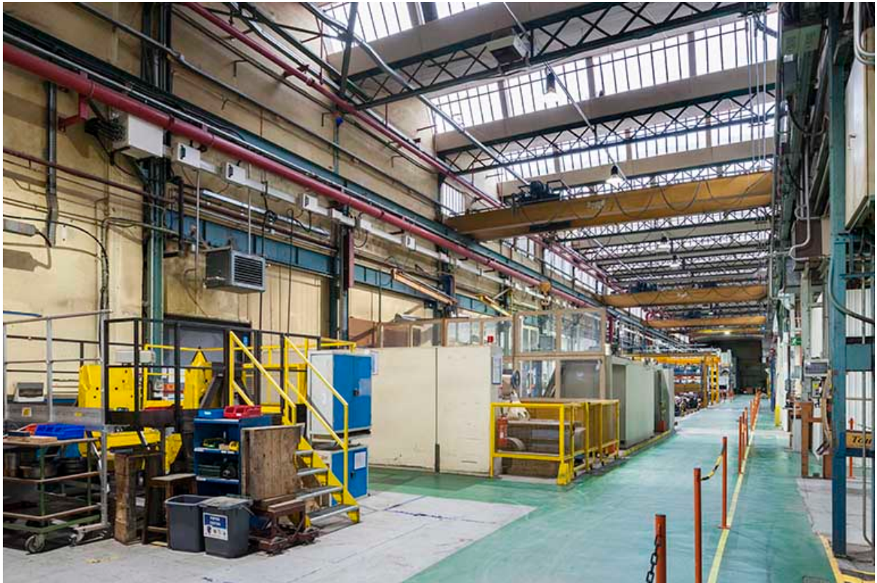
Hall central. Vue de côté.
