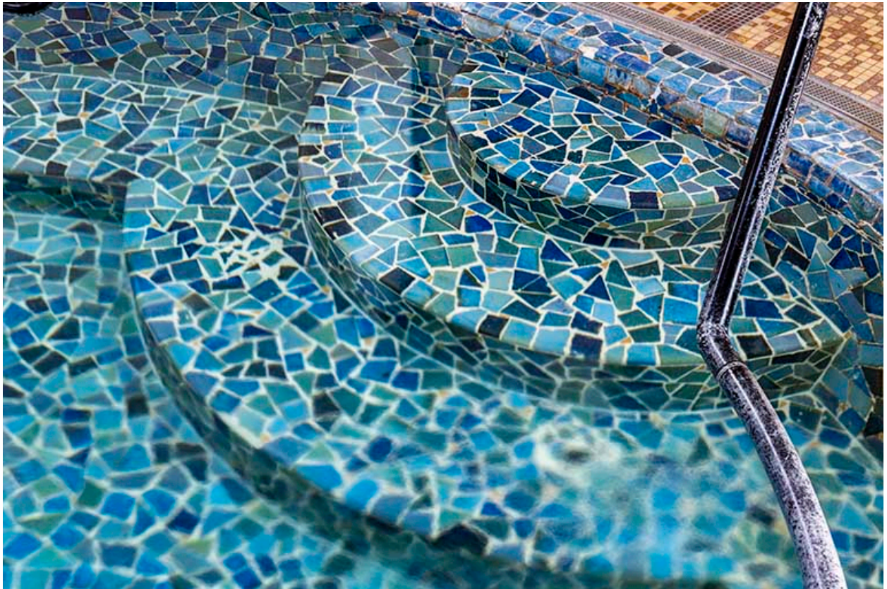
Piscine à l'emplacement du Grand Bain, détail du bassin, degré d'accès.
