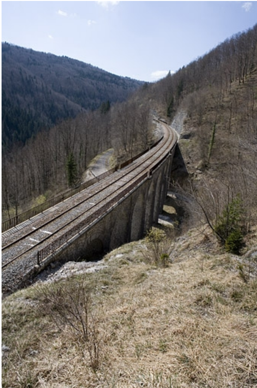
Vue d'ensemble des viaducs et de la voie, depuis le nord-est (côté Andelot-en-Montagne).
