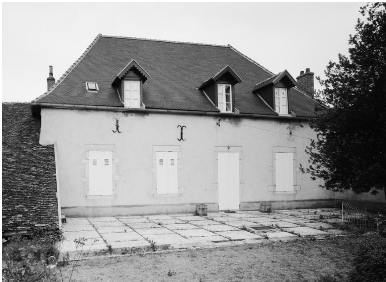
Façade postérieure du logis.
