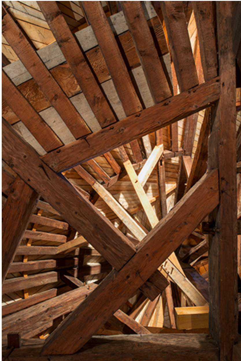
Enrayure nord-est de la charpente du dôme.
