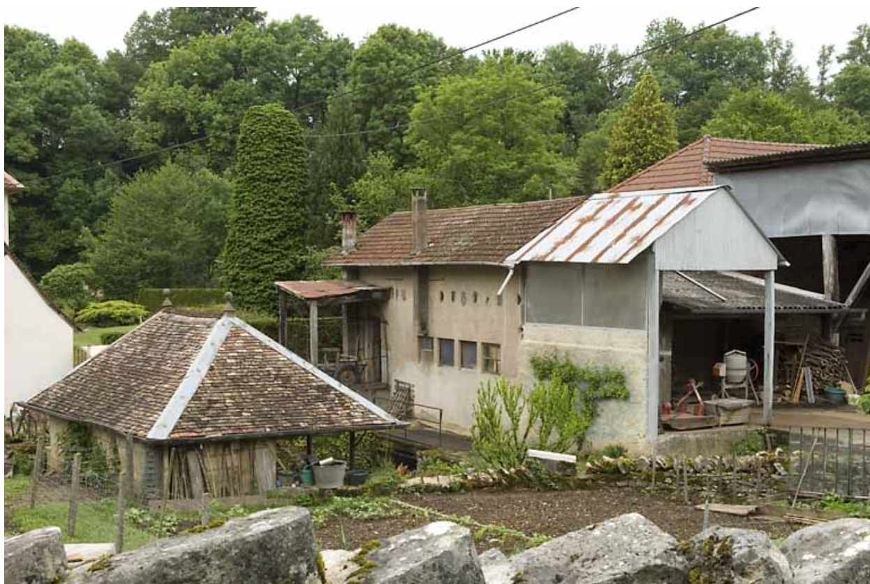
Les bâtiments industriels depuis le sud-est.
