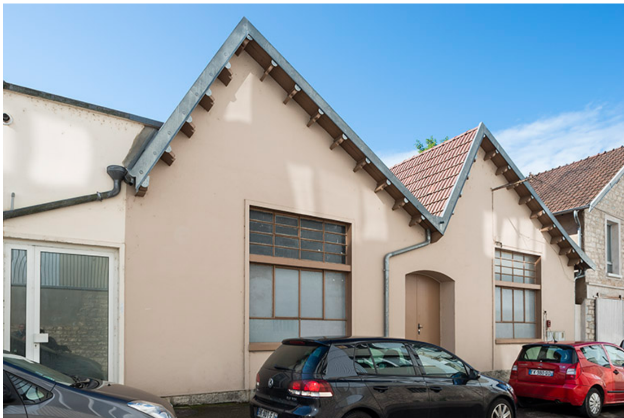
Murs-pignons des sheds sur le rue Klein.
