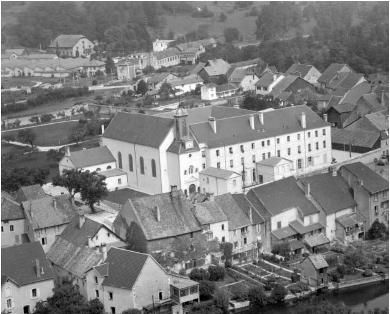
Vue générale après la rénovation de 1981-1983.
