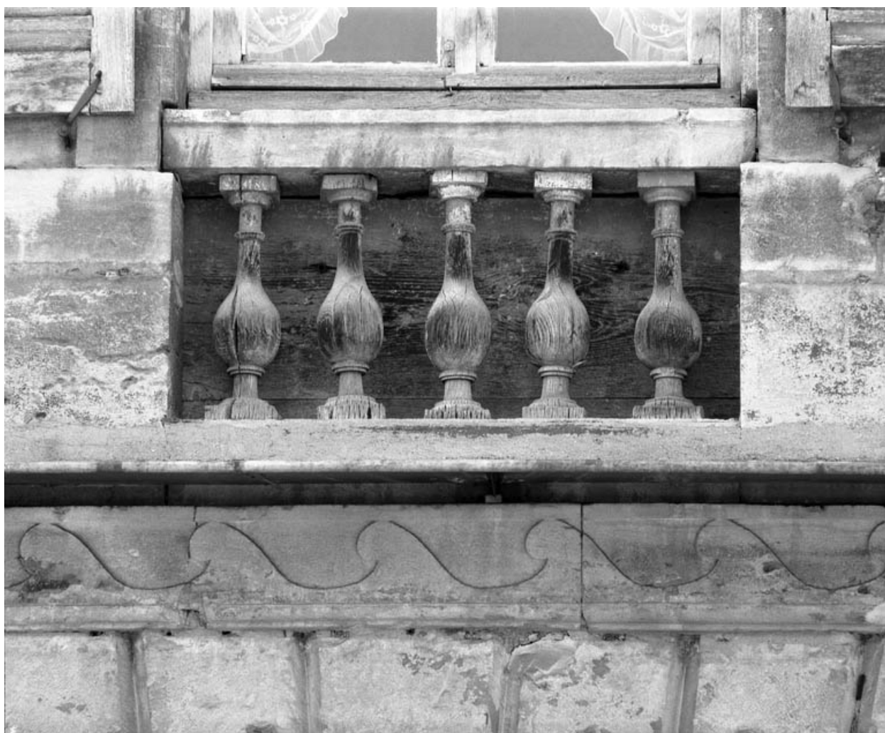
Façade antérieure : détail d'un garde-corps.
