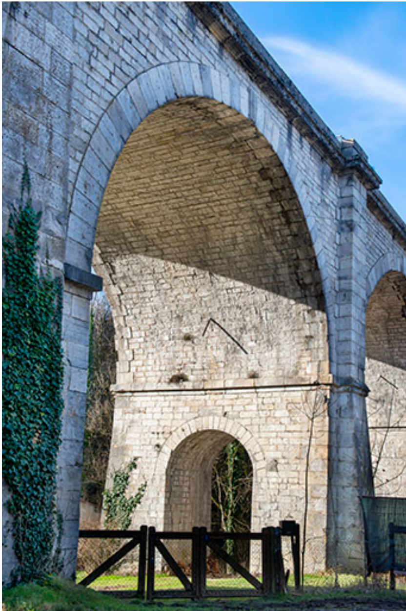
Vue rapprochée de l'arche est.
