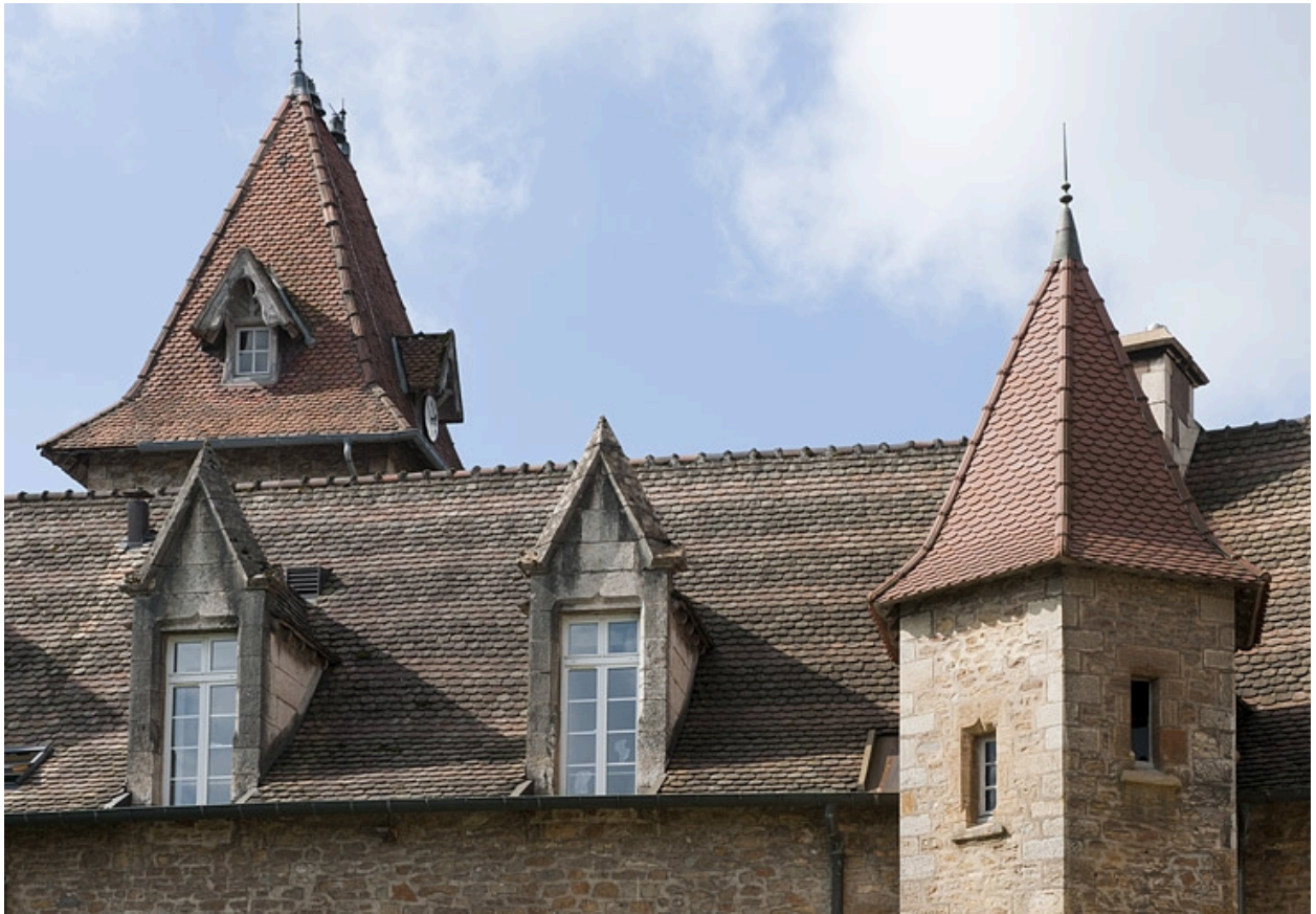
Bâtiment (C), façade côté jardin : détail des toits.
