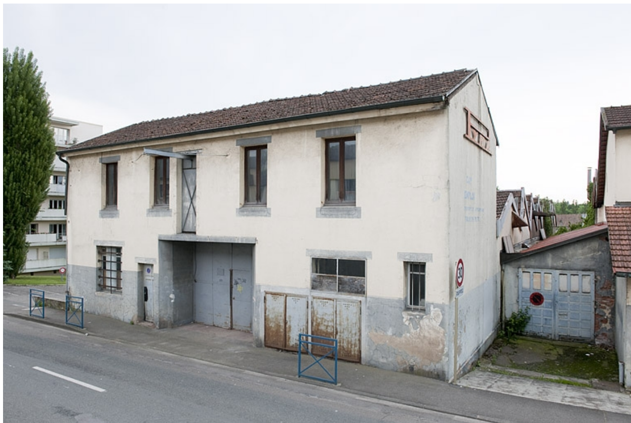
Bâtiment sur rue (logement ?).
