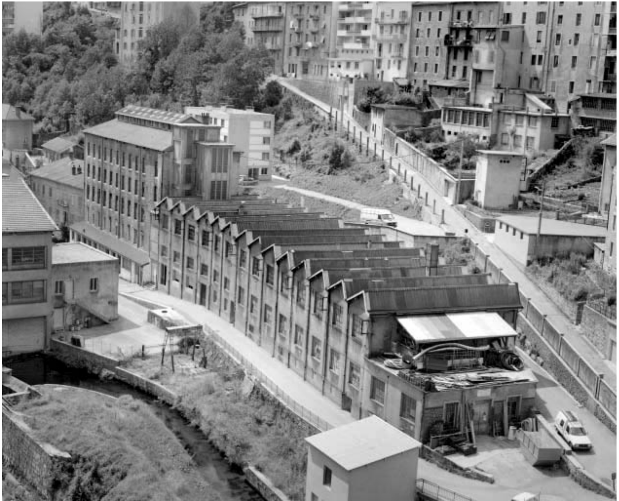
Vue d'ensemble de la taillerie, de la cristallerie et de la verrerie Dalloz, depuis le nord-est.
