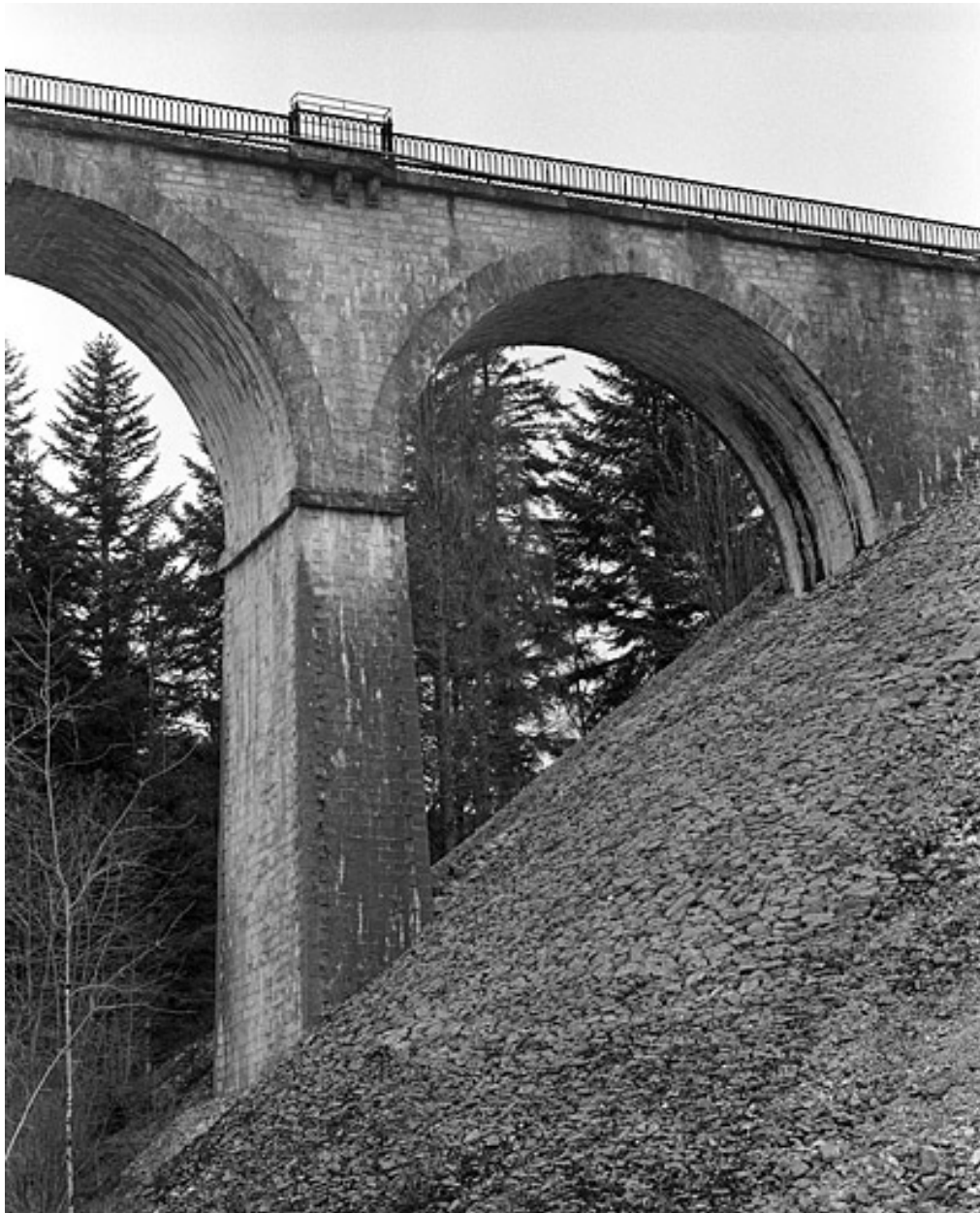
Première arche côté Andelot-en-Montagne, depuis l'est.
