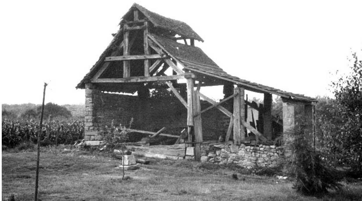
Hangar (abri du four), depuis l'est.
