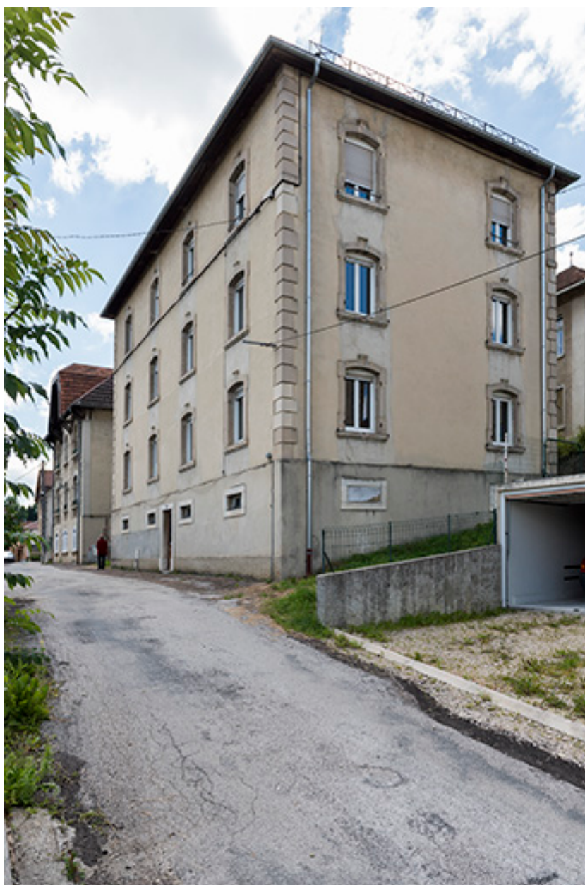
Façades antérieure et latérale droite.
