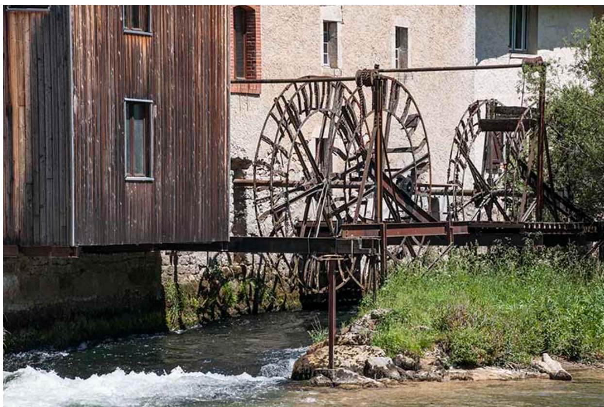
Roues hydrauliques depuis l'aval.
