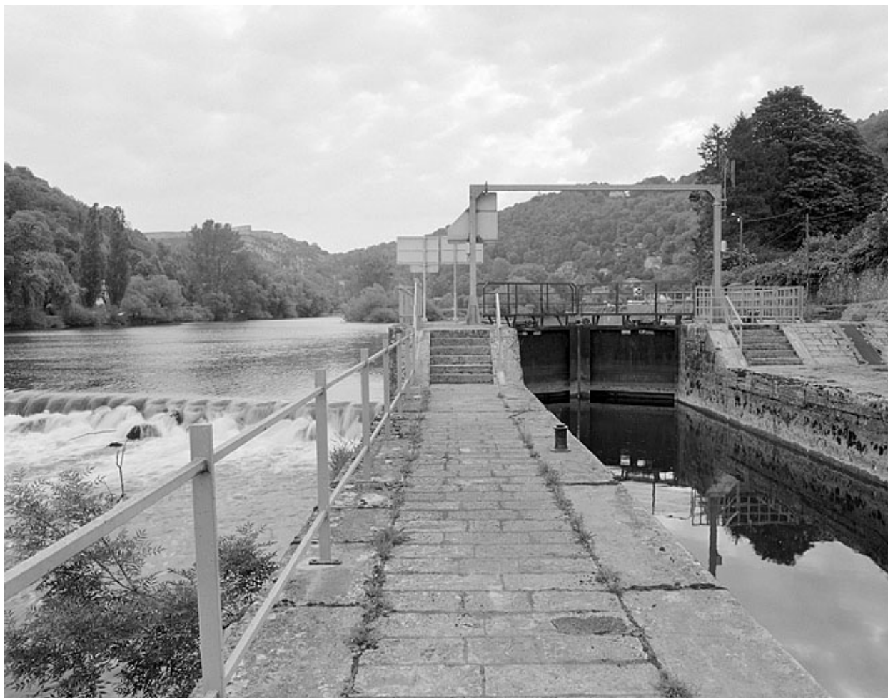
Porte amont de l'écluse et barrage.
