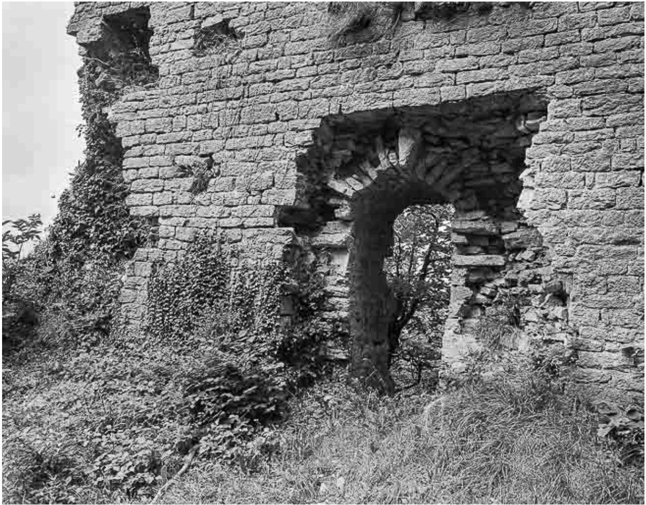
Vue extérieure du donjon : détail d'une porte.
